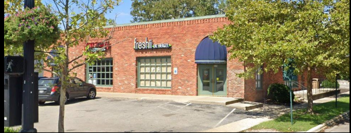
2510 E. Main St., Bexley
